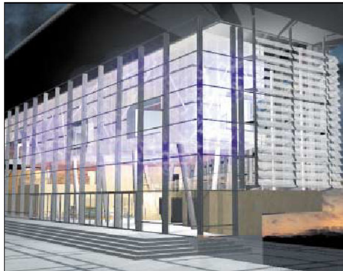
Fassade Belvedere Kirchberg
